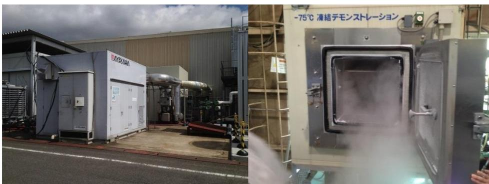
図 4. 超低温急速凍結に使用したパスカル冷凍機とチャンバー
